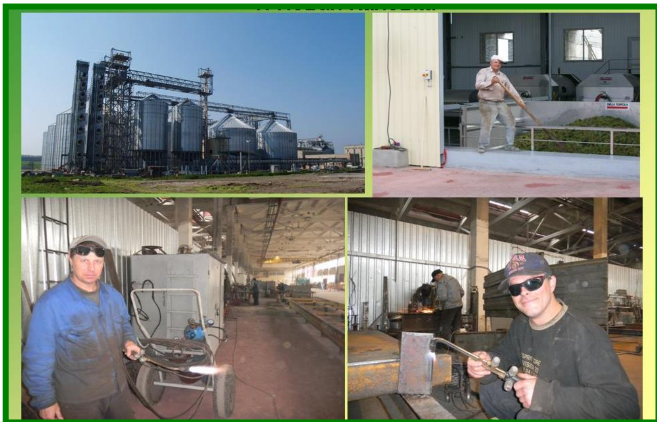
Фото №3. Будівництво сосевого заводу «Каховка Пром-Агро»
